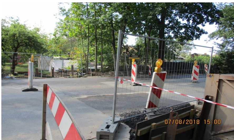
7. attēls. Siltumtīklu izbūves un pārbūves darbi Rīgā, Krustpils ielā 83
