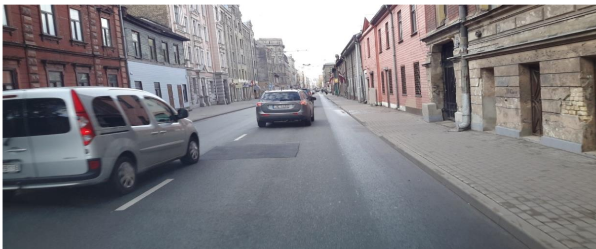
2. attēls. Remontdarbi Avotu ielā iepretim namam Nr. 70.
