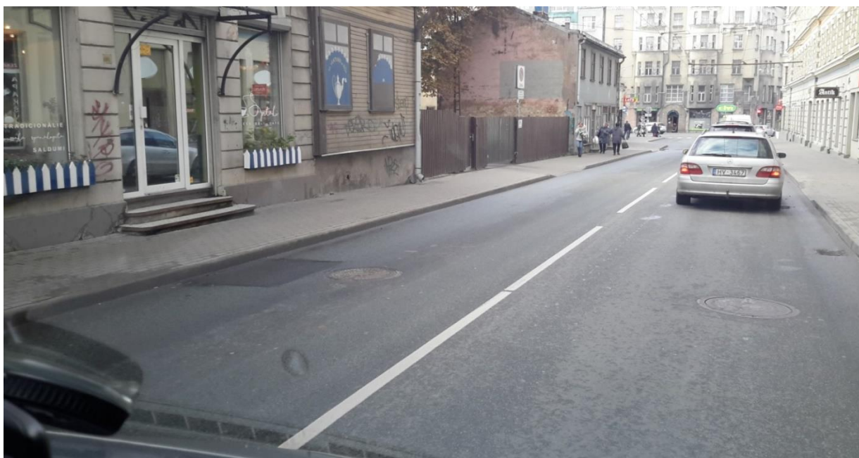
7. attēls. Remontdarbi Avotu ielā iepretim namam Nr. 30
