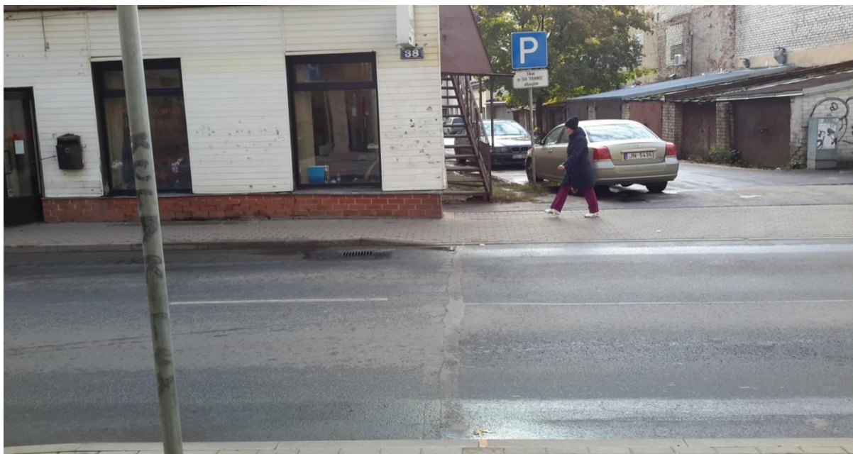
5. attēls. Remontdarbi Avotu ielā iepretim namam Nr. 38
