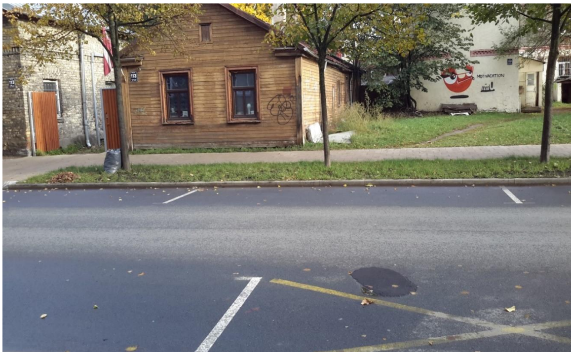
14. attēls. Remontdarbi Stabu ielā iepretim namam Nr. 113 (2018. gada 9. oktobris).
