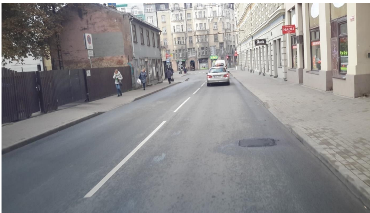
8. attēls. Remontdarbi Avotu ielā iepretim namam Nr. 30
