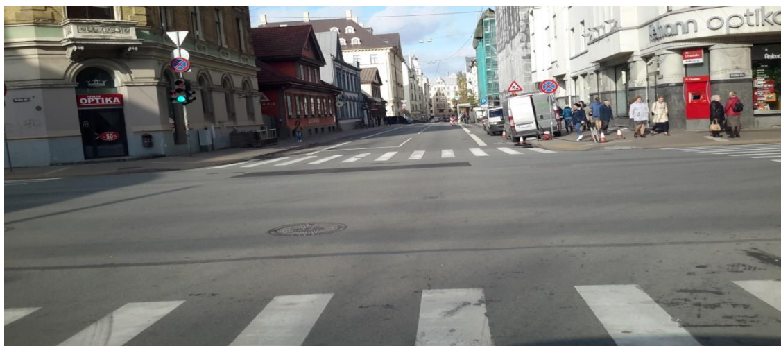
11. attēls. Remontdarbi Lāčplēša ielas un Brīvības ielas krustojumā
