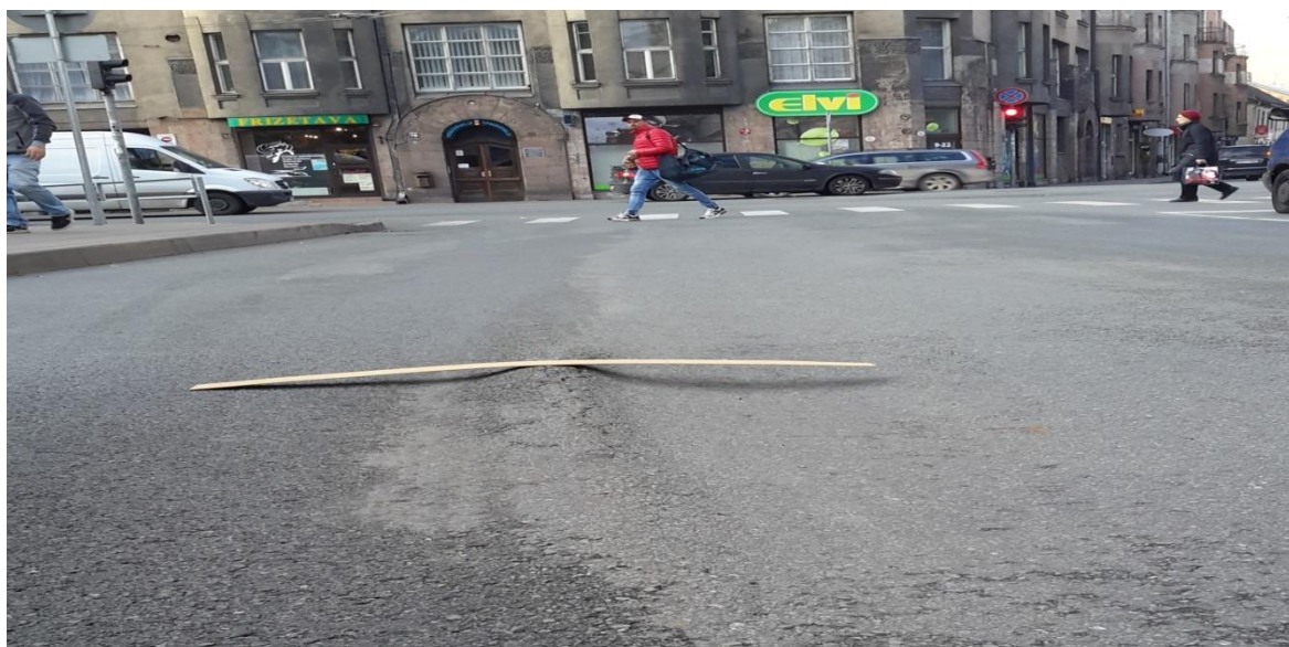
9. attēls. Asfalta sabīdījums pie pieturas “Avotu iela”
