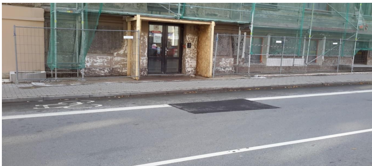
10. attēls. Remontdarbi Lāčplēša ielā iepretim namam Nr. 59
