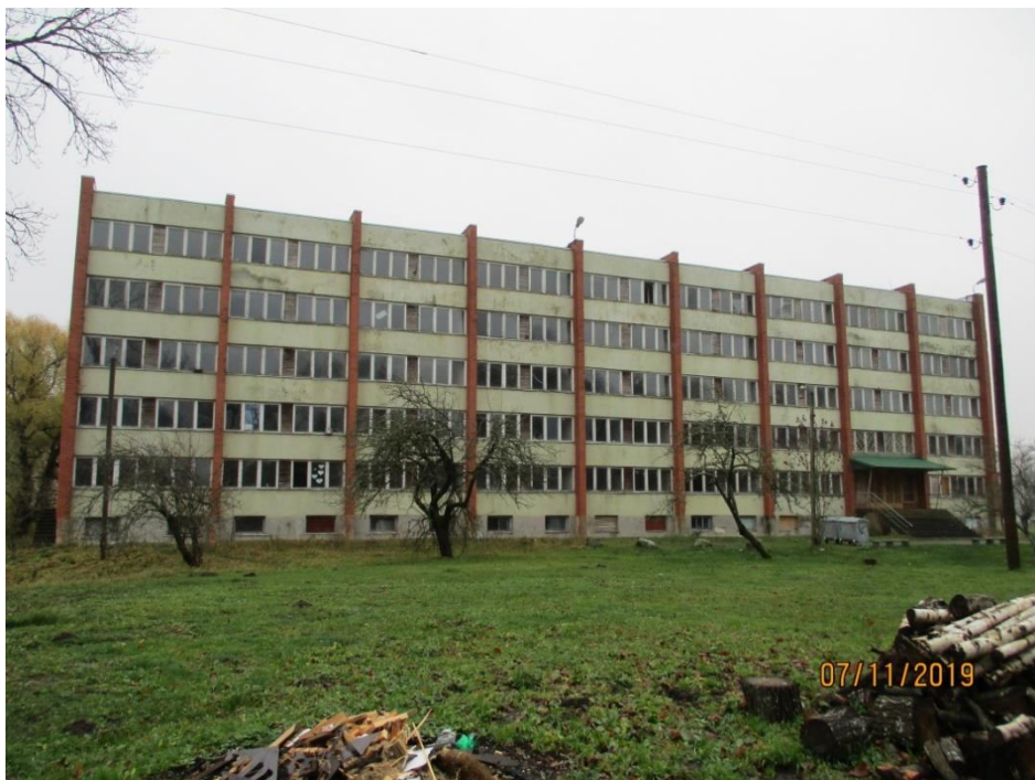
Kandavas Lauksaimniecības tehnikuma IPĪV Cīravā neizmantotā dienesta viesnīca
