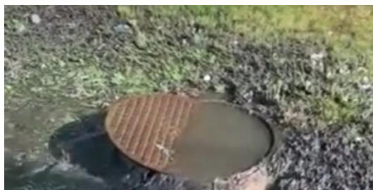
13. attēls. No lietus ūdeņiem pārplūdusi kanalizācijas aka.
